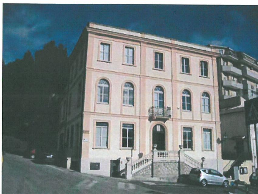
L'intervento si inserisce nel progetto definitivo/esecutivo "Efficientamento energetico e sismico Municipio - Mis. A. 2 linea 1", effettuato nel Comune ed ha avuto ad oggetto: opere interne che non hanno alterato l'aspetto esteriore dell'edificio; interventi di coibentazione volti a migliorare l'efficienza energetica degli edifici; interventi di consolidamento statico degli edifici, ivi compresi quelli necessari per il miglioramento o l'adeguamento ai fini antisismici.
