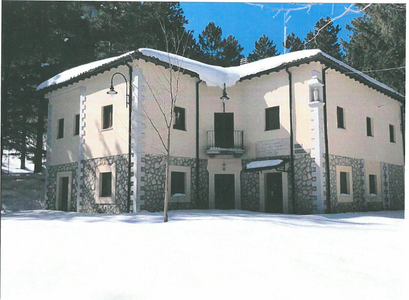
Gli interventi, in linea con l'ordinanza del Commissario Straordinario del Governo n. 120 del 13 Agosto 2021, hanno avuto ad oggetto la risistemazione della copertura del fabbricato con sostituzione dei coppi rotti e riparazione della guaina bituminosa; sostituzione dei canali di gronda e discendenti pluviali; rifacimento tinteggiature interne ed esterne; risistemazione tettoia in ferro; rifacimento parte di recinzione; sostituzione apparecchiature danneggiate della cucina.
